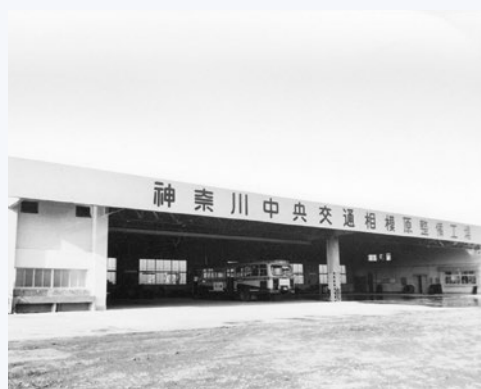
最大規模となった相模原営業所整備工場
