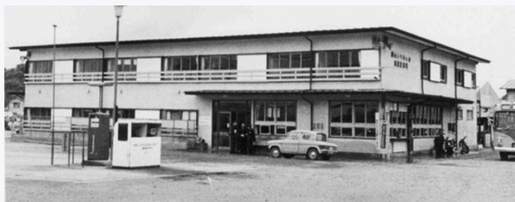
新設した舞岡営業所
