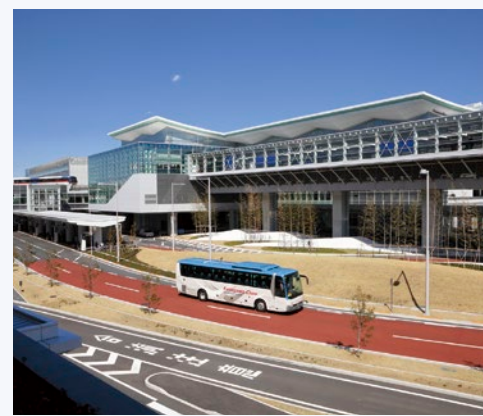
羽田空港新国際線ターミナルに乗り入れを開始した空港連絡バス
