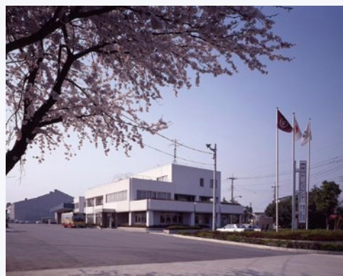
新設した綾瀬営業所
