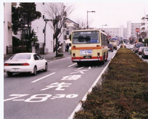
藤沢市内に設置された“中央側車線”のバス優先レーン
