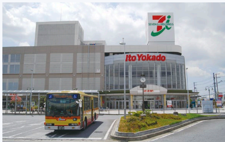
戸塚営業所跡地に整備された立場ターミナル
