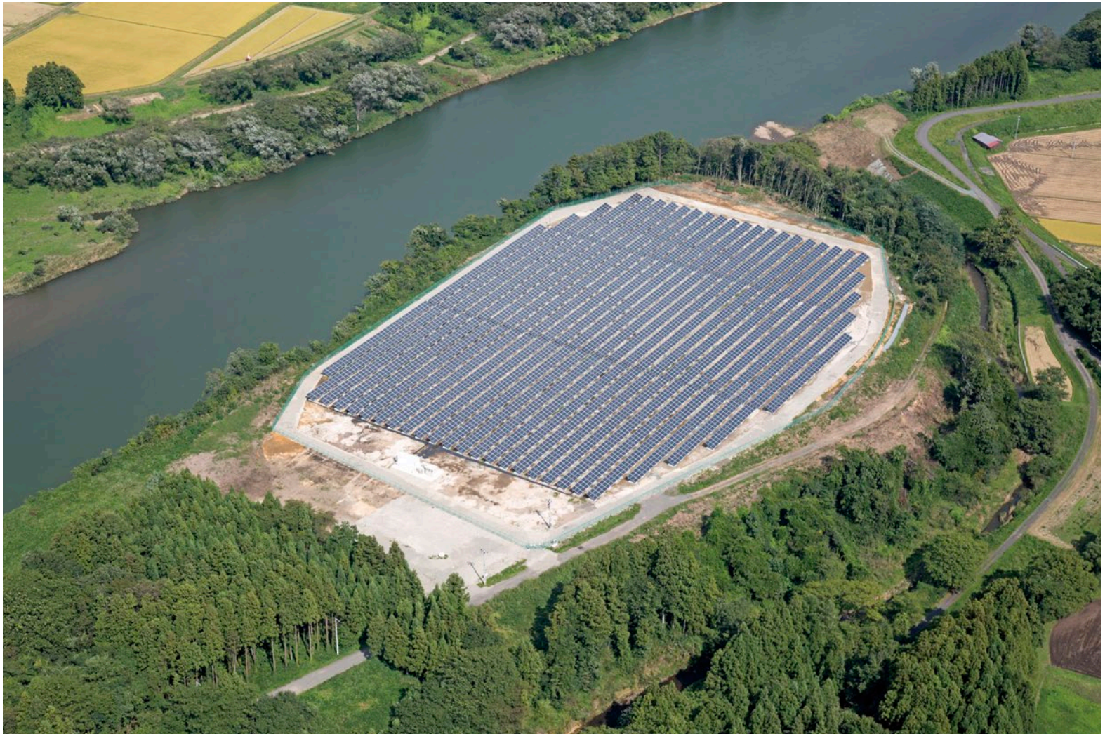
岩手県胆沢郡金ケ崎町に建設した太陽光発電所（2015年）
