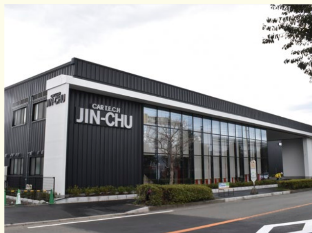
新築移転した本社工場（神中興業）
