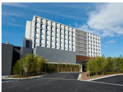
「HOTEL CLAD」外観
